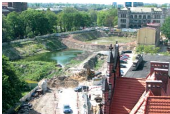
Fundamenty NFM, zdj. Urząd Miasta we Wrocławiu
