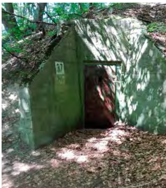
Bunkry po odpowiednim dostosowaniu stanowią będą miejsca schronień dziennych i miejsc zimowania nietoperzy. Fot. T. Bajor.
